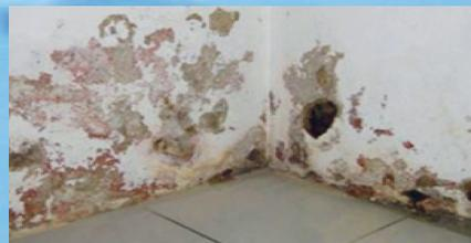
... dann sind die Schäden schnell sichtbar, mit Vergrauungen und Schimmelbildung usw. ...
